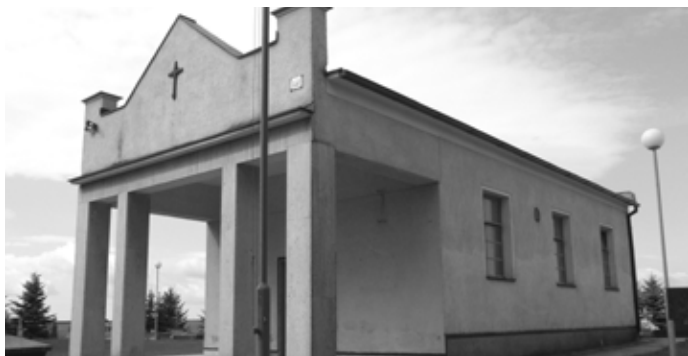
Pôvodný stav pred rekonštrukciou
