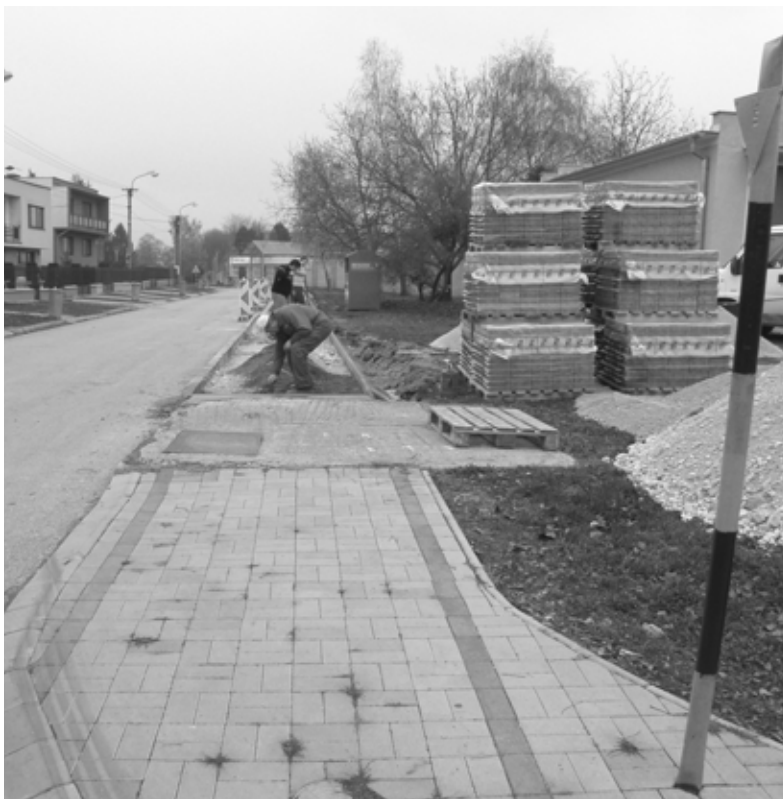
Začatie prác na na chodníku - Nová ulica
