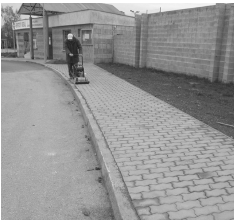
Práce na chodníku finišujú
