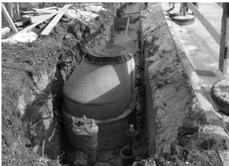
predĺženie vodovodu a kanalizácie na ul. Záhradná 009
