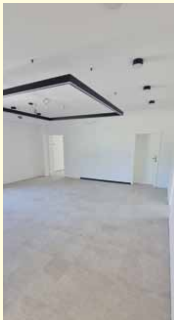
Priestory nového obecného úradu.
