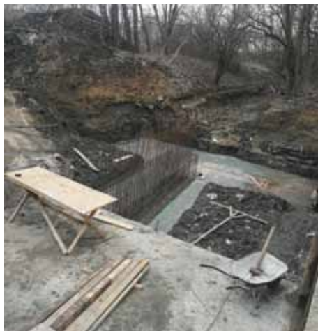
Príprava kalovej jamy
