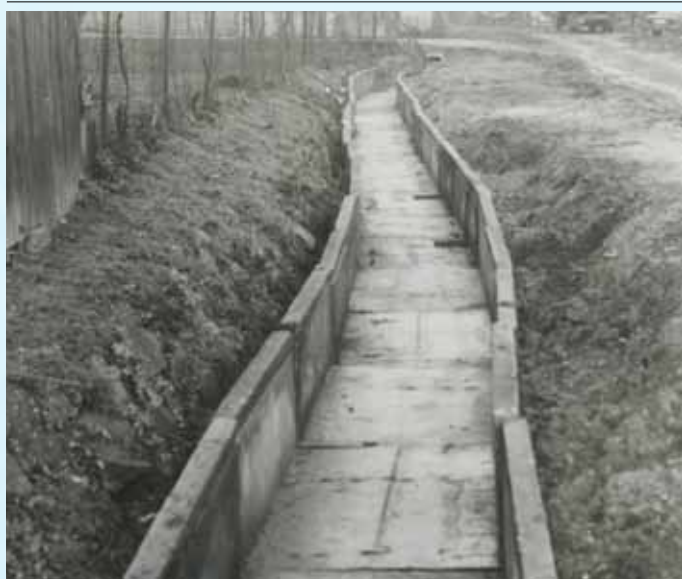
Odvodňovací kanál za materskou školou na Záhradnej ulici. Fotka je z obdobia jeho budovania. Foto: archív fotiek z histórie našej obce
