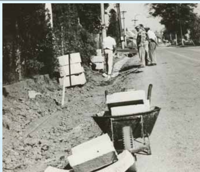
Brigáda pri budovaní odvodňovacích kanálov. Foto: archív fotiek z histórie našej obce
