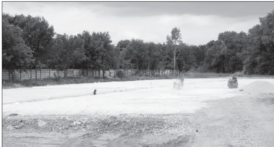
● Budovanie dvorcov je v plnom prúde.
