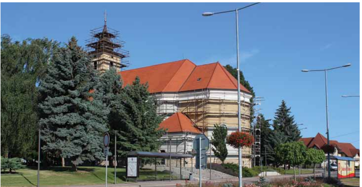
Kostol sv. Michala „zdobí“ lešenie – dostane novú fasádu a veža nové pokrytie (Foto: BH)
