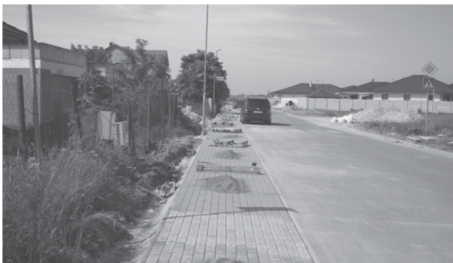
Výstavba chodníka na Lipovej ulici je pred ukončením
