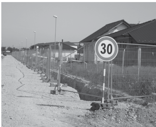
Výstavba teplofikácie na Jablonoňovej ulici
