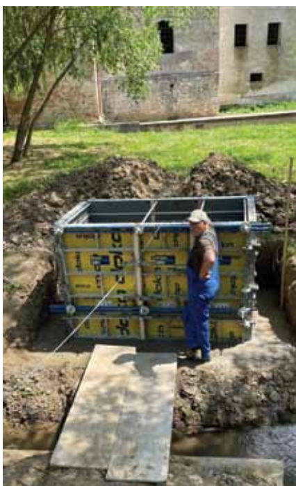
Príprava pilierov pre lávku Na mlyne
