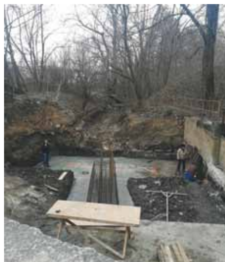
Prípravné práce pre kalovú jamu
