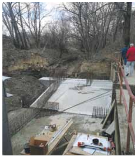
Výstavba kalovej jamy
