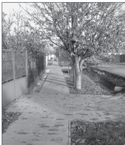
● Nový chodník na Cintorínskej ulici
