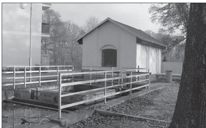
● Čerpacia stanica závlahového vododu
