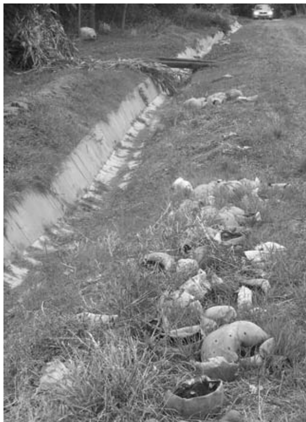
Okolie odvodňovacieho kanála v Paderovciach
