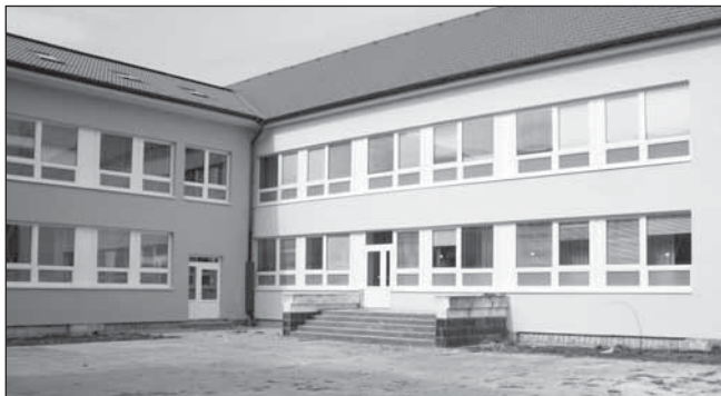
■ Vchod do knižnice v základnej škole.
