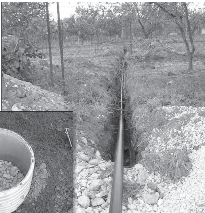
■ Na odsúhlasených miestach je už závlahový vodovod položený.
