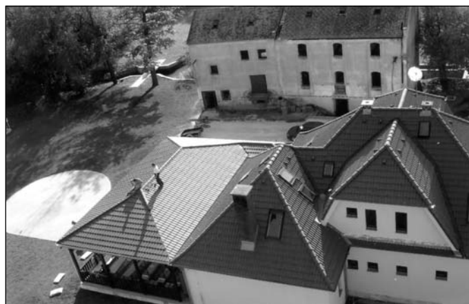
● Vtáčí pohľad na pôvodné mlynské stavby. Peter Paulovič by mal určite radosť, že krásny areál bude ľudom opäť slúžiť.
