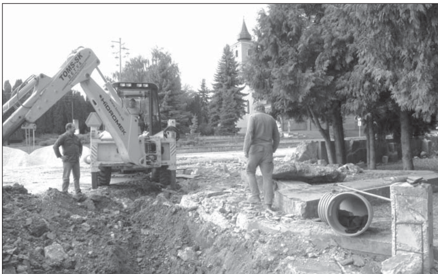
● Práce na rekonštrukcii námestia budú mať estetický i bezpečnostný dopad.
