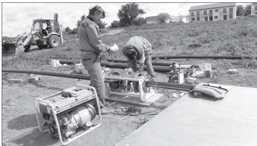
● V novej stavebnej lokalite bude k dispozícii aj vodovod.
