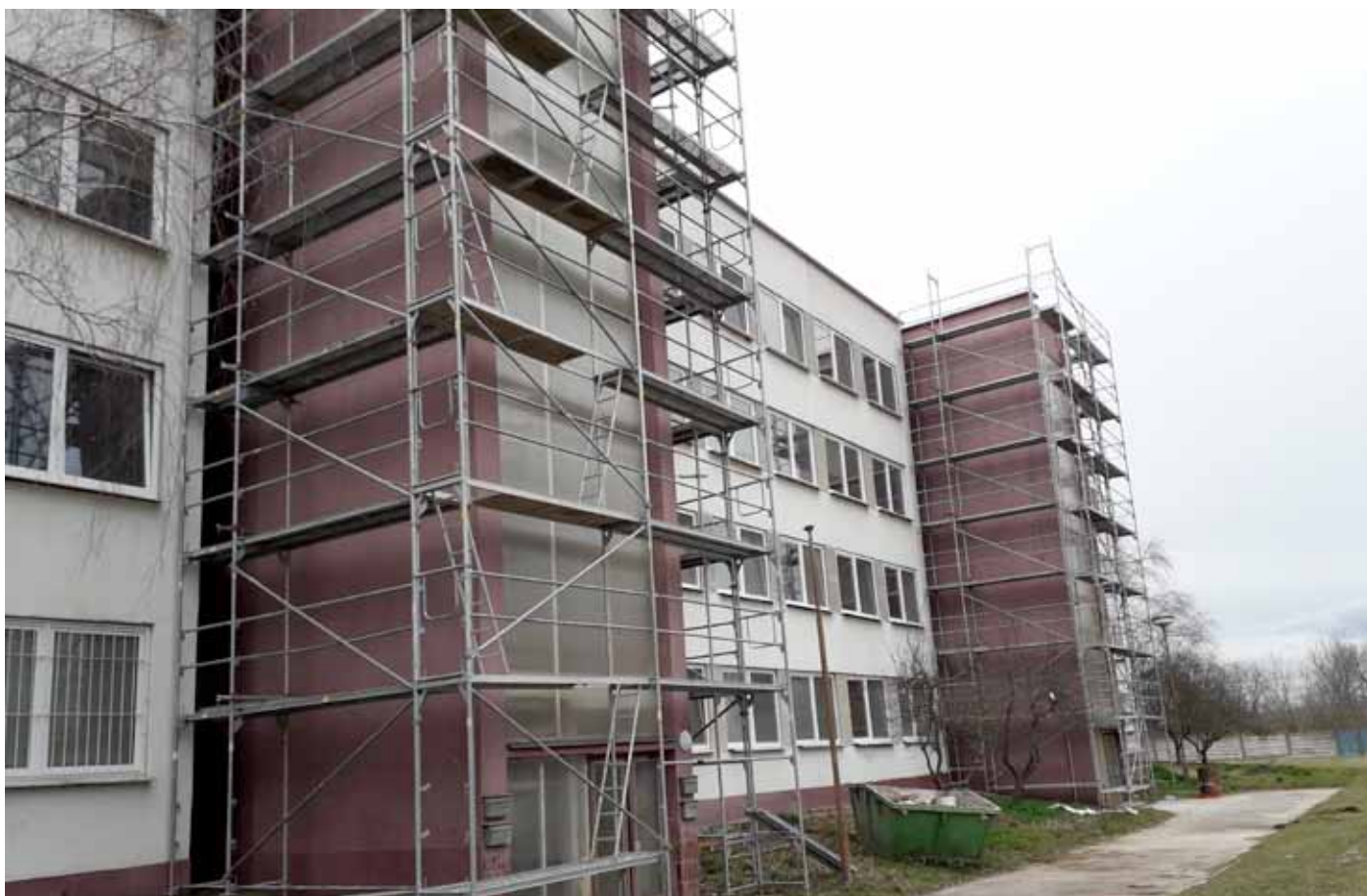
Rekonštrukcia schodísk na Ubytovni
